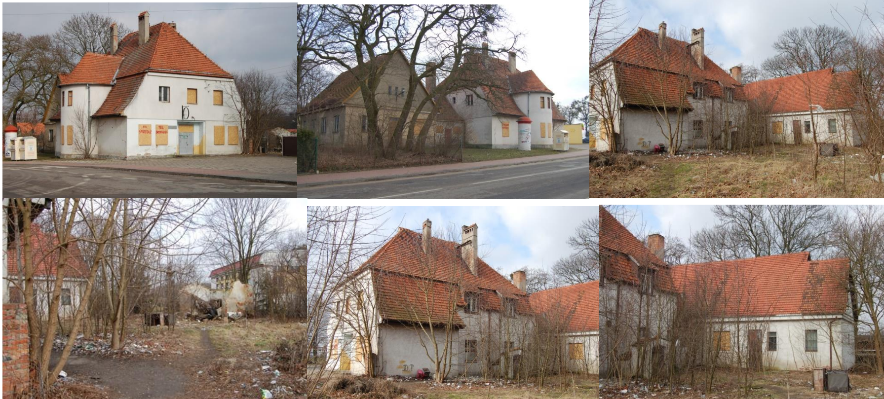
Fotografie: Zdegradowany, historyczny budynek w centrum Chłudowa - własność Gminy Suchy Las
