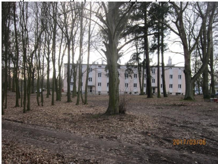
Fotografie: Niezagospodarowany park przy blokach mieszkalnych w Biedrusku – własność Gminy Suchy Las
